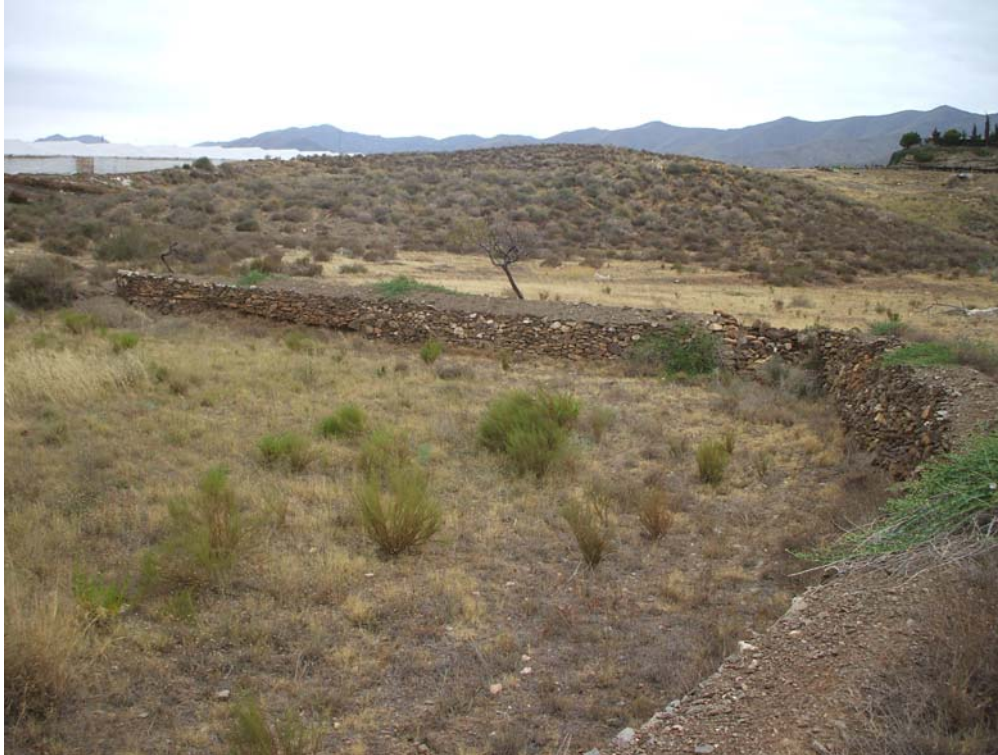
Muro de contención.
