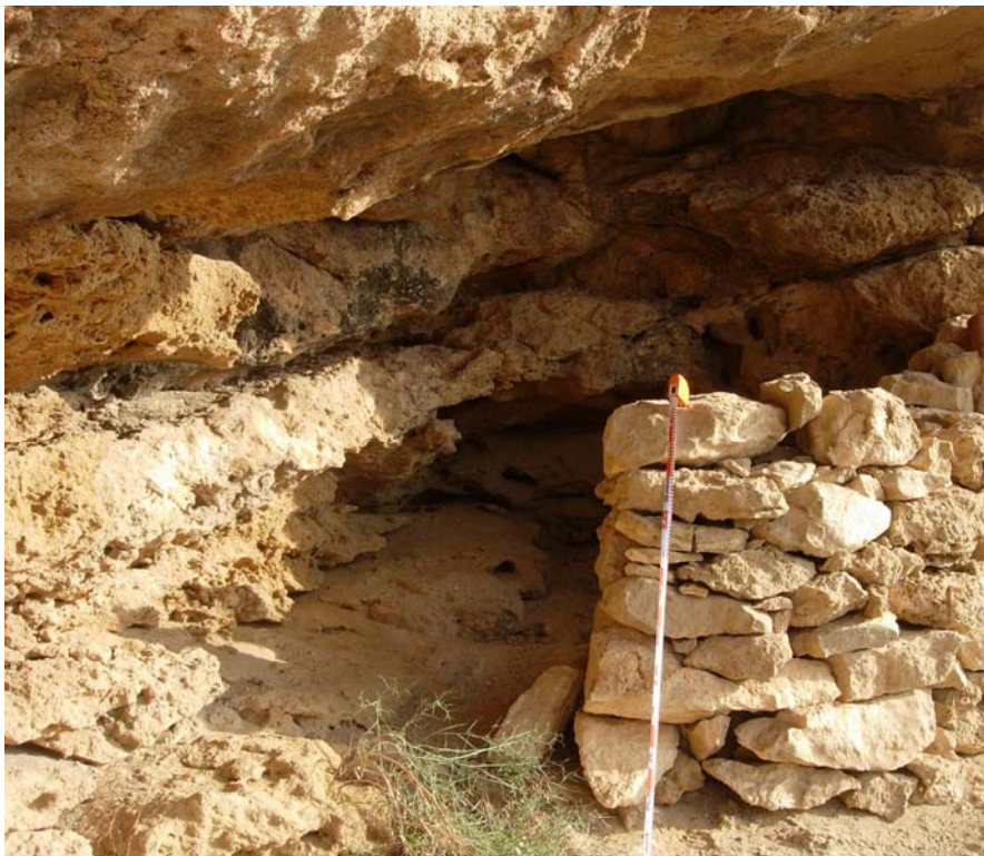
Parapeto en Cabo Cope II.
